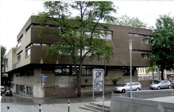
Ansicht der Südwestfassade der Norishalle
